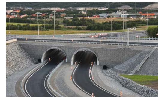
Путепровод на ПК 4+45, Р-21 «Кола» на участке км 1378 — км 1381, Мурманская область
