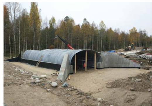
Скотопрогон на ПК59, Р-21 «Кола» на участке км 424 — км 445, Республика Карелия
